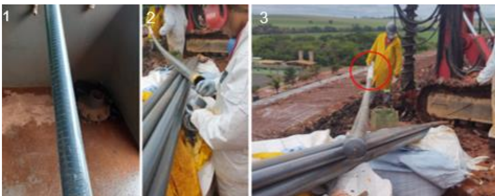
Figura 11 - Etapas de montagem – 1. Realização de Ranhura, 2. Colagem de cap (vedação do tubo) e 3. Ranhura protegida com tela telcon branca.
