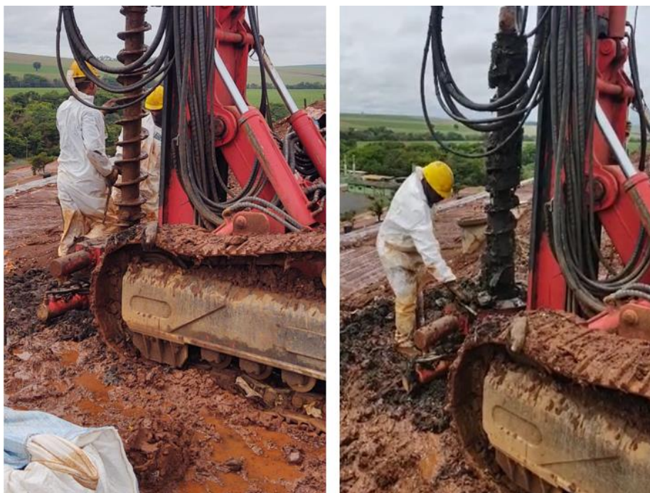
Figura 12 – Perfuração piezômetro vector elétrico (esq.) e Retirada dos trados pós perfuração (dir.)
