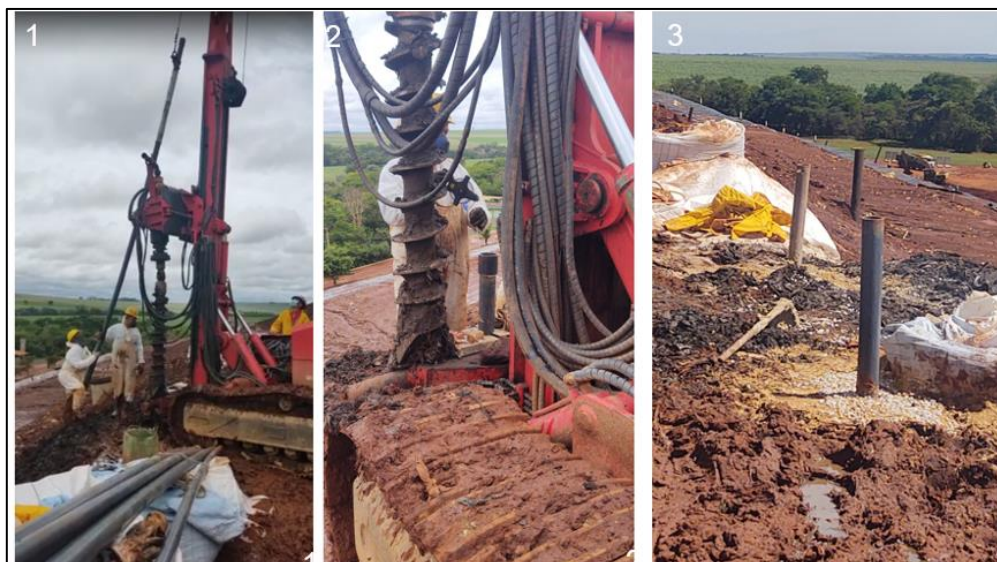
Figura 13 - Etapas de montagem – 1. Colocação do tubo externo (3”), 3. Conferência de profundidade sendo realizada e 3. Instalação Tubo externo instalado, e apresentação de distância do vector convencional.
