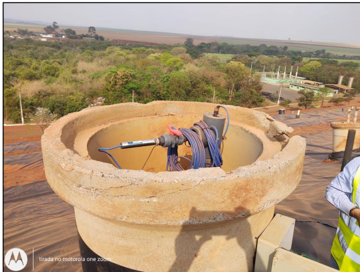
Figura 17 – Piezômetro protótipo vector elétrico durante visita técnica realizada em setembro de 2022 (
